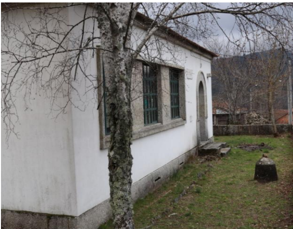
Vista geral do edifício
