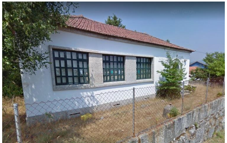
Vista geral do edifício
